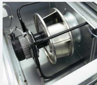
Revisionsmöglichkeiten für Filter und ventilator von oben, unten und seitlich.
