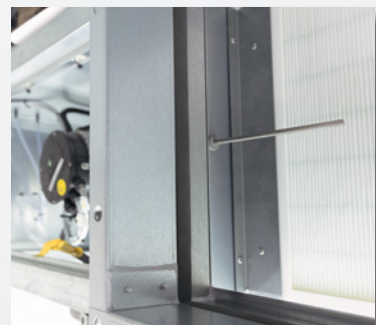
Temperaturfühler eingebaut und auf Schaltschrank verdrahtet.
