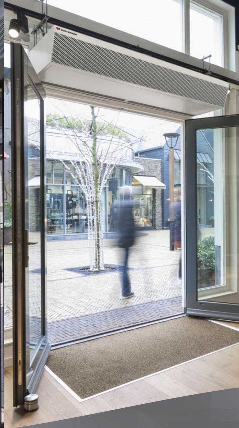
Sichtmontage an der Wand oder unter der Decke.
